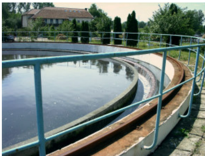
Satu Mare: Decantorul stației de epurare a apelor uzate
